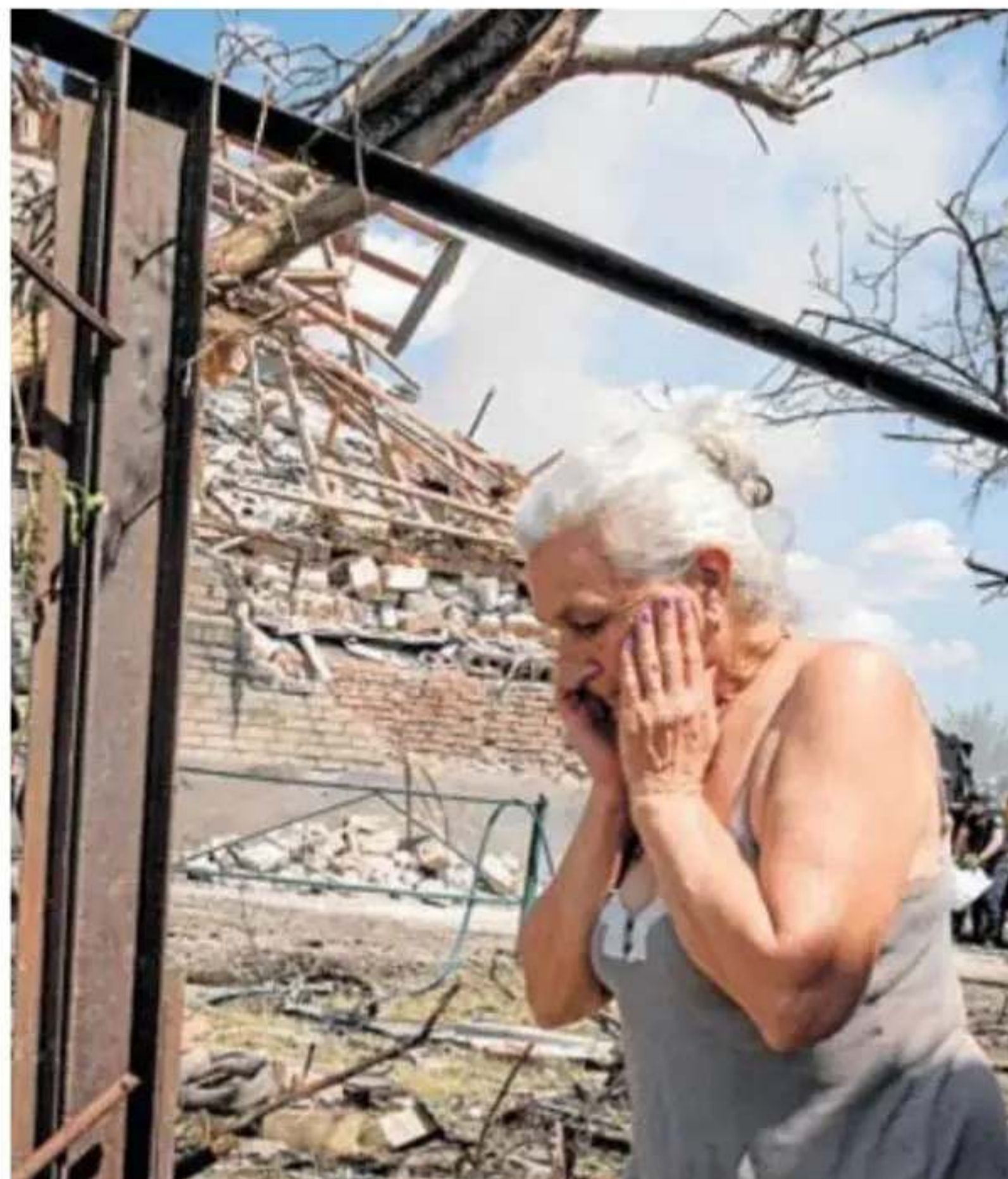
Una vecina de Kramatorsk, entre los escombros de su casa. Reuters
